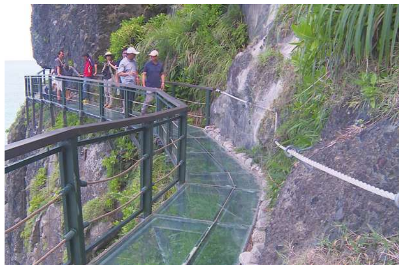
▲花蓮豐濱鄉天空步道自7月1日開始試營運不滿2週，12日遭人蓄意破壞，豐濱鄉公所表示，已修復完成，預計13日再度對外開放，由於難以找到破壞者，不打算提出毀損告訴。
